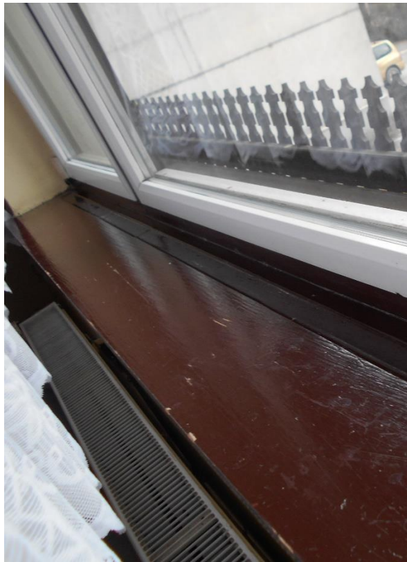
Slika 4: Radiator nameščen pod okno
